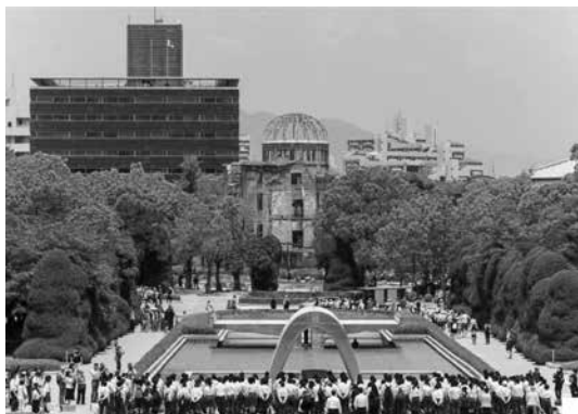
Kenzo Tange, Parco del Memoriale della Pace, Hiroshima, 1954. In primo piano il Cenotafio per le vittime dell'esplosione nucleare, opera di Arto, 1964; in lontananza la Cupola della bomba atomica, unico edificio rimasto in piedi dopo il disastro, patrimonio dell'UNESCO dal 1996.
