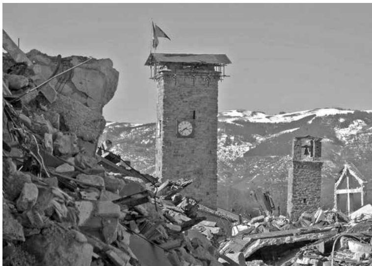
Amatrice distrutta dal terremoto del 24 Agosto 2016.
